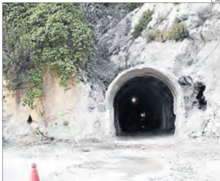
La primera galeria d'evacuació que s'ha perforat.
