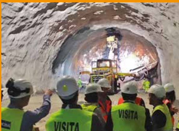
Visita a les obres d'excavació del túnel de Trespons. 23 de maig de 2019
