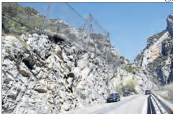
Instal·len xarxes de protecció per evitar la caiguda de roques.
