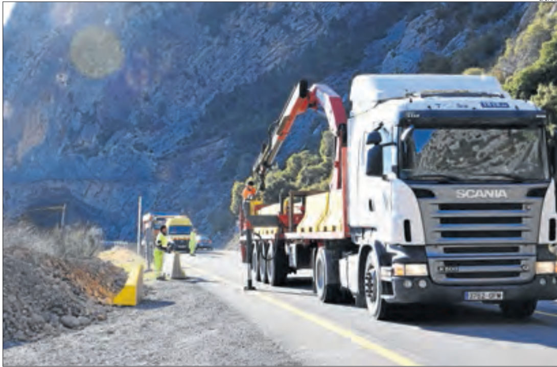
Operaris van instal·lar barreres de seguretat a la C-14 ahir a la tarda.
