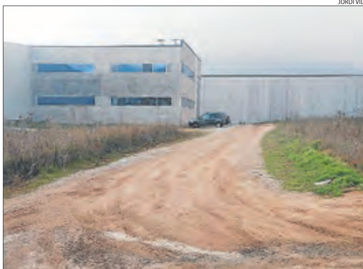
El tram d'avinguda limita amb el polígon industrial.
