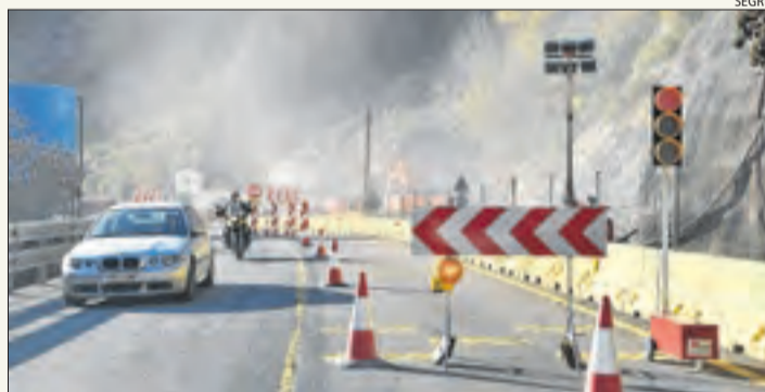
Imatge d'arxiu de les obres del túnel de Tres Ponts.
