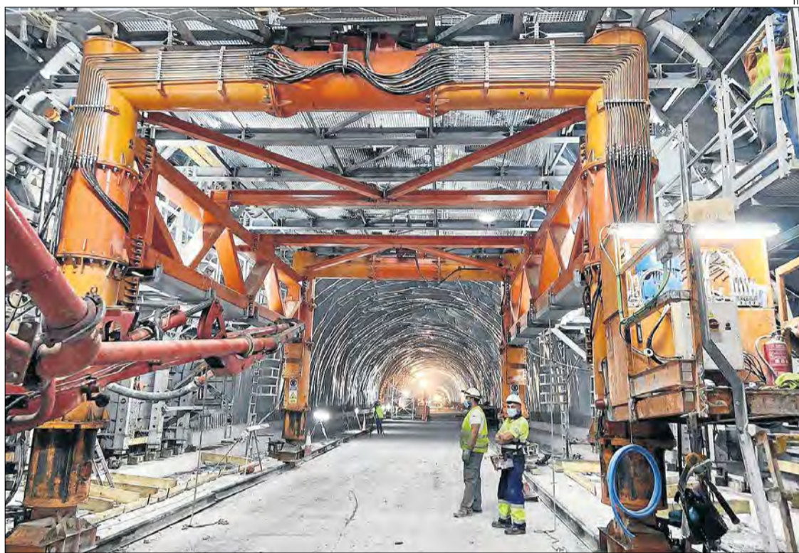
L'excavació del túnel ja està a punt i ara es procedeix al revestiment i la resta d'acabats.
