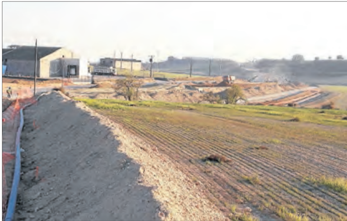
Les obres en curs de la nova variant de Balaguer.
