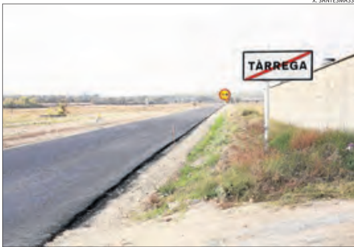
Imatge dels treballs que s'han portat a terme a l'LV-2021.
