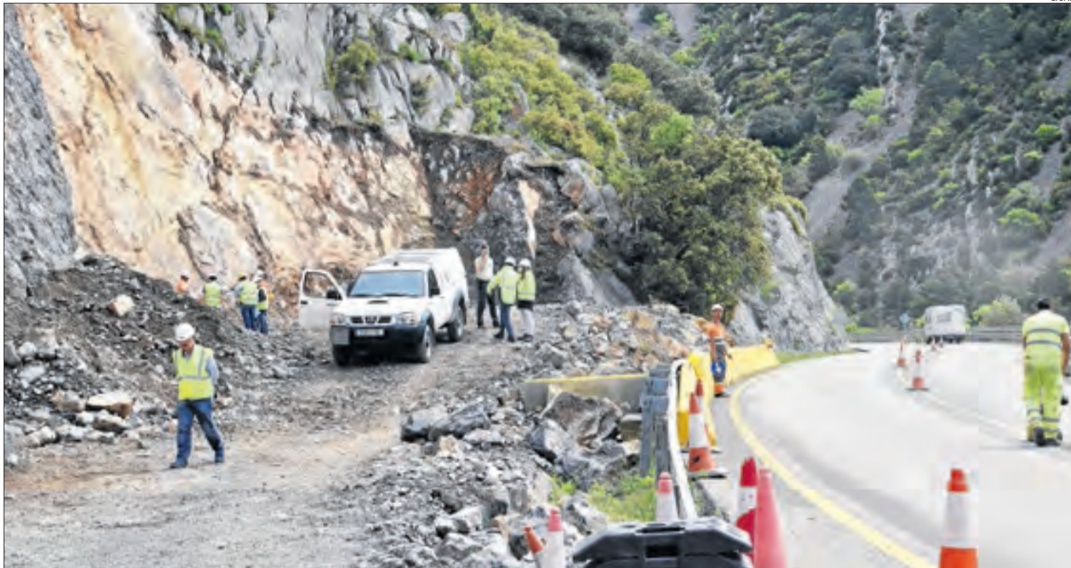
Les explosions es van portar a terme al migdia i van tenir poca afectació al trànsit de la C-14.
