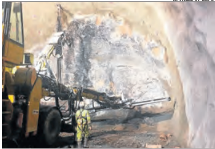
Imatge dels treballs de perforació del túnel de Tres Ponts.
