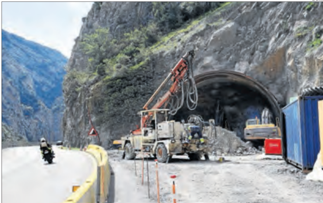
De moment, els operaris han pogut excavar els primers nou metres de la boca nord.
