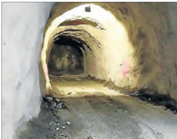
Imatge de l'interior de la galeria d'evacuació inacabada.
