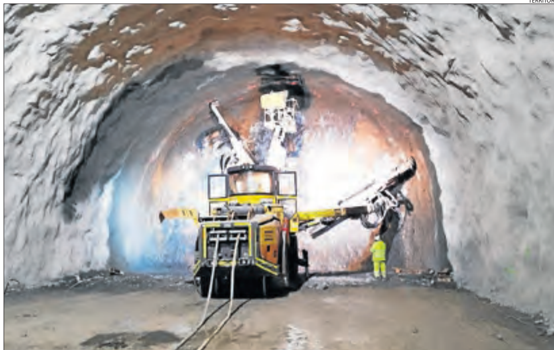
Imatge de l'interior del túnel de Tres Ponts, que ja està perforat en un 50%.
