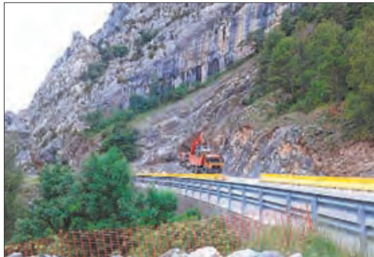
FOTO: Dept. Territori / Màquines començant els treballs de perforació
