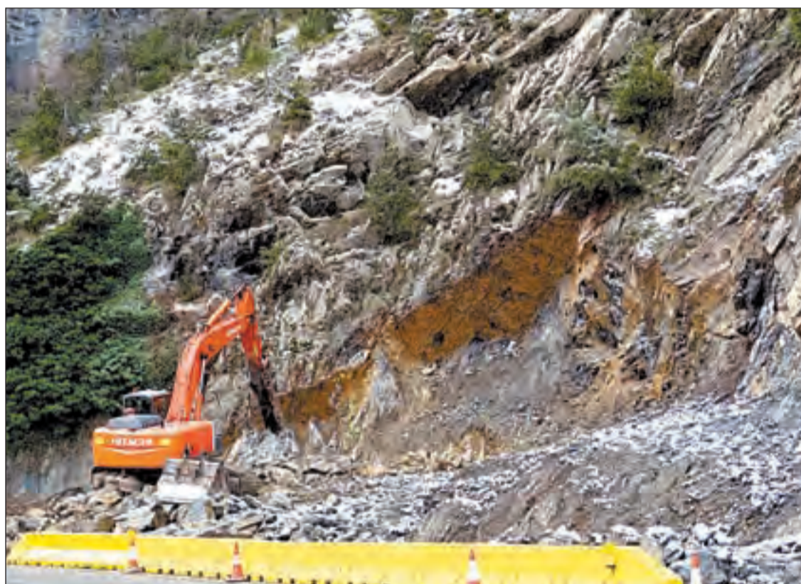
FOTO: Dep.Territori / Punt on es començarà a perforar la nova galeria, que tindrà una longitud de 1,3 Km
