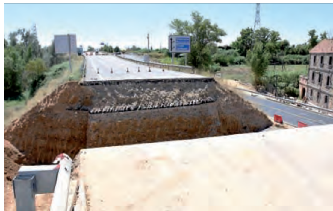
FOTO: Núria García / Els operaris ja han excavat
