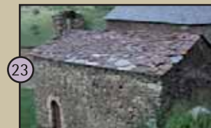
23 Sant Martí de Biscarbó Petita església documentada des de finals del segle XI. La senzillesa i la rusticitat de la seva construcció fa pensar en una tradició constructiva més antiga.
