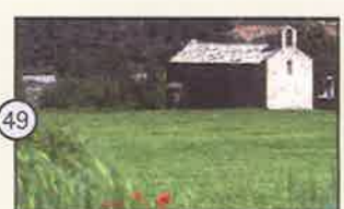
49 Santa Lúcia de Tragó temple érigé au XIe siècle aux alentours du village actuel de Tragó, ce qui rehausse l'ensemble. Il présente une partie avant trilobée très particulière.
