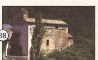
38 Sant Esteve d'Alinyà église consacrée en 1057 par l'évêque Guillem Guifré d'Urgell, puis reconstruite au début du XIIe siècle avec de grandes pierres de taille rectangulaires.
