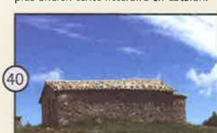
40 Santa Pelaia de Perles petit ermitage de style roman, construit au XIIe siècle. Si le ciel est dégagé, il est possible d'apercevoir depuis Pelais de Perles deux autres ermitages de la région : Sant Ponç d'Alinyà et Santa Fe d'Organyà.
