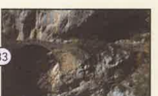
33 Els Pontarrons route construite lors de la première moitié du XIe siècle, sous le patronage de l'évêque Ermengol de Urgell, pour circuler dans les gorges de Trespons.
