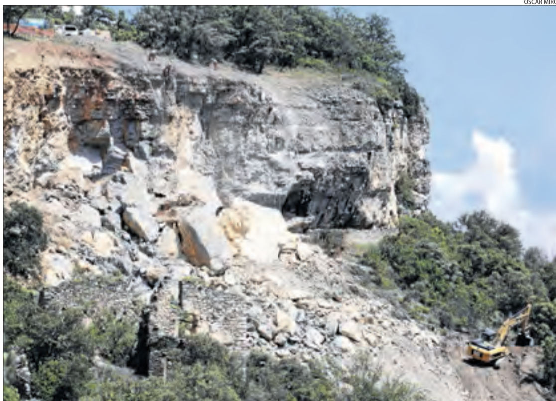
Les màquines van començar ahir a retirar les primeres roques de la carretera de Castell de Mur.
