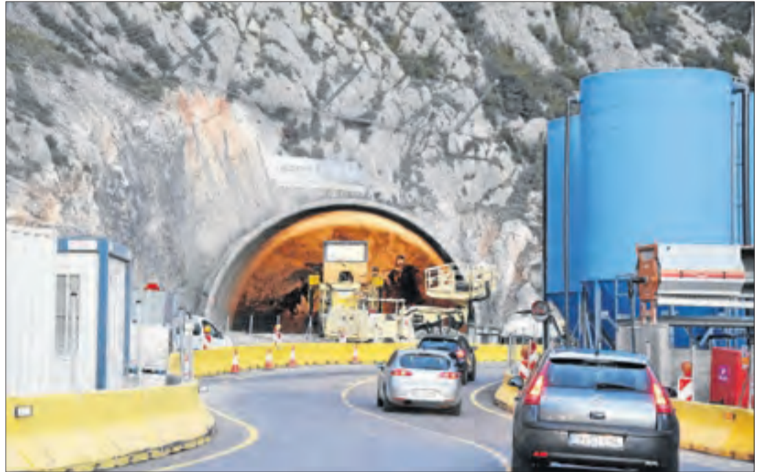
Els operaris treballaven ahir en una de les dos boques del túnel de Tres Ponts.
