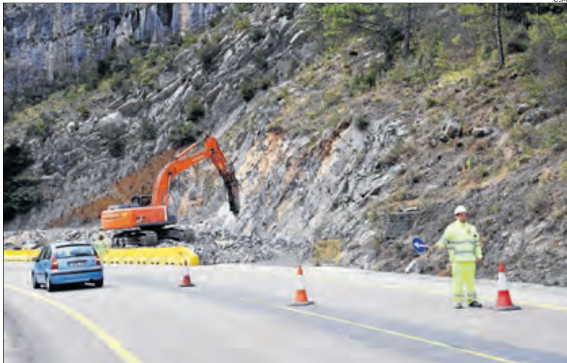
Una màquina treballant a la boca nord del futur túnel de Tres Ponts.
