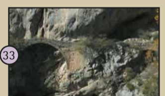
33 Els Pontarrons Obra viària construïda a la primera meitat del segle XI, sota el patrocini del bisbe Ermengol d'Urgell, per circular per l'estret de Trespons.
